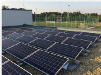
12 KWP TELJESÍTMÉNYŰ NAPELEMES RENDSZER TELEPÍTÉSE A HORVÁTH OTTÓ SPORTKÖZPONT ÉPÜLETÉN
