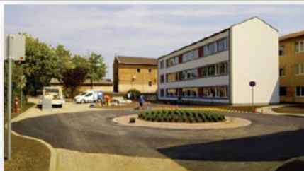
ÚJ ISKOLASZÁRNY ÁTADÁSA, ÁTKÖTŐÚT ÉS 36 ÚJ PARKOLÓHELY LÉTREHOZÁSA
