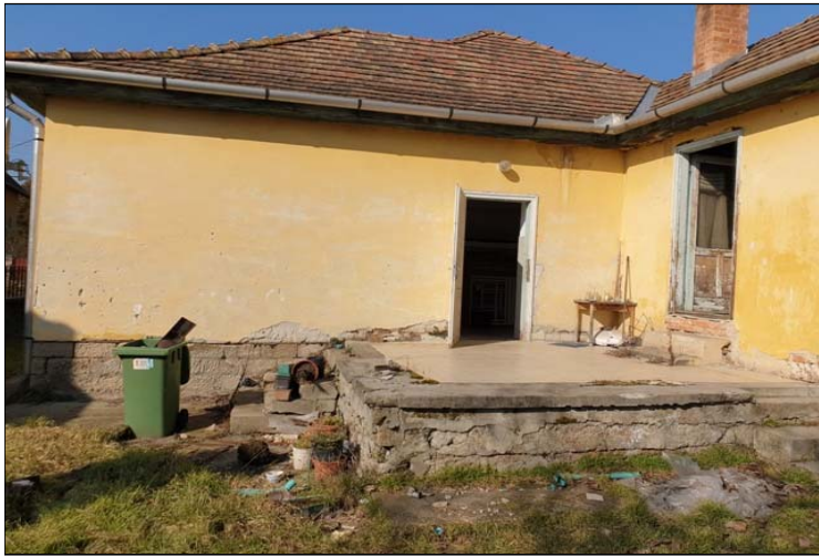
Hátó homlokzat, terasz
