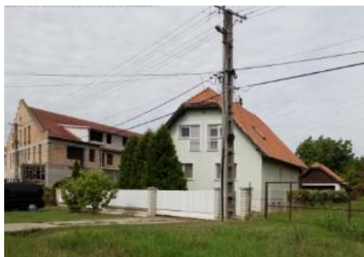
Széchenyi István utcában épülő lakóházak (forrás: saját kép, 2022)
