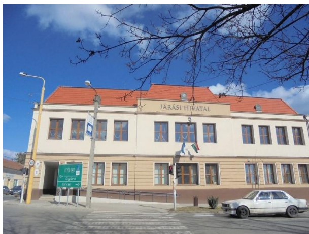
Járási Hivatal épülete
